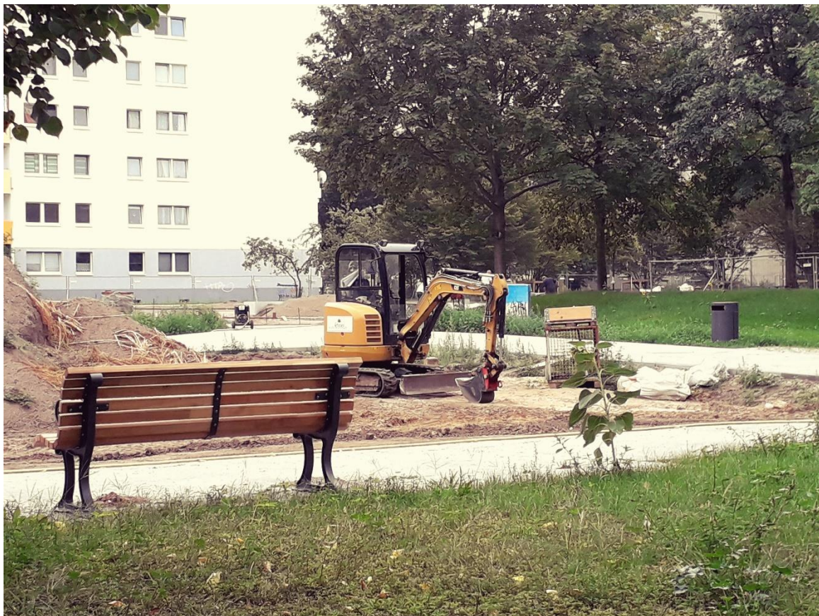
Bautätigkeit im Teilbereich an der Venusstraße (Bild: QM Kosmosviertel)
