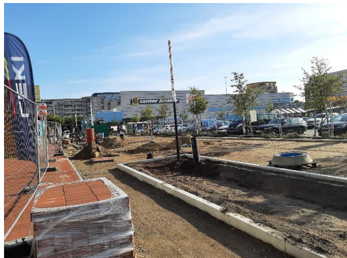
Bautätigkeit in der Ladenpassage
